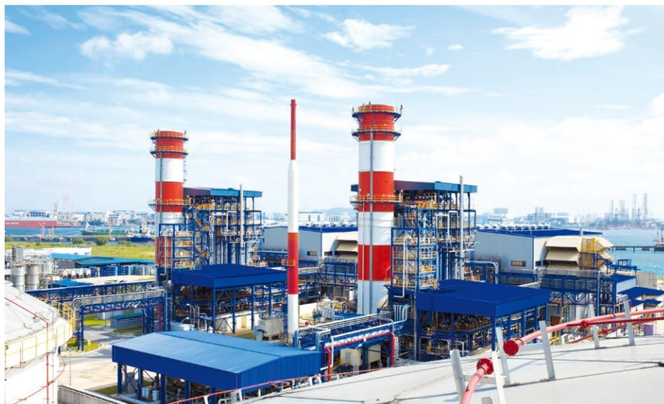
第一太平及Meralco PowerGen透過一家彼等分別持有60%及40%權益的合營公司擁有PLP 70%權益。PLP是新加坡首間以全液化天然氣為燃料的發電廠，配備這先進技術所能提供之最高效益的設施。該發電廠的燃料由BG集團按其一項長期協議，通過新加坡政府興建的SLNG碼頭而提供。其複循環燃燒渦輪機發電廠由兩座各可負荷400兆瓦，以天然氣為燃料而淨發電量共達781兆瓦的渦輪機組成。PLP之發電廠已於二零一四年二月一日開始商業營運。
